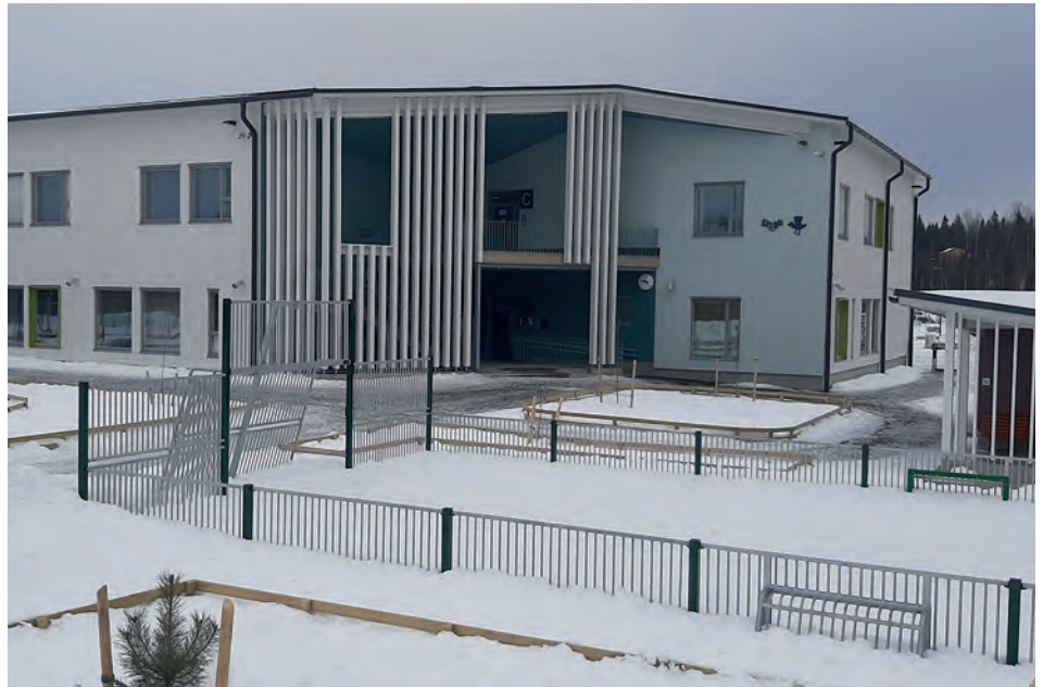
Tampereen Tilapalvelut Oy:n rakennuttama Isokuusen päiväkoti ja koulu otettiin käyttöön Tampereen Vuoreksessa tammikuussa 2022. Kuva: Tampereen Tilapalvelut Oy
